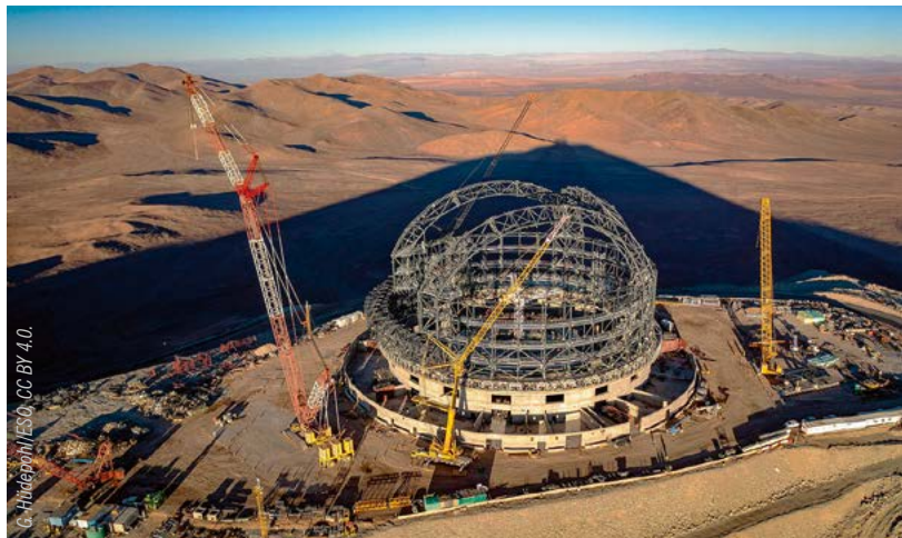
Ārkārtīgi lielā teleskopa celtniecība 2023. gada augustā.
